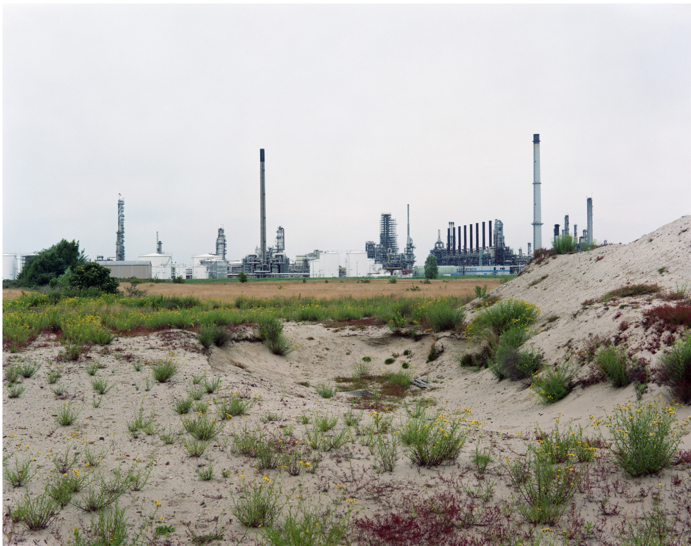
ZUIDELIJKE RANDWEG / MOERDIJK / NOORD-BRABANT / NETHERLANDS / 2013
