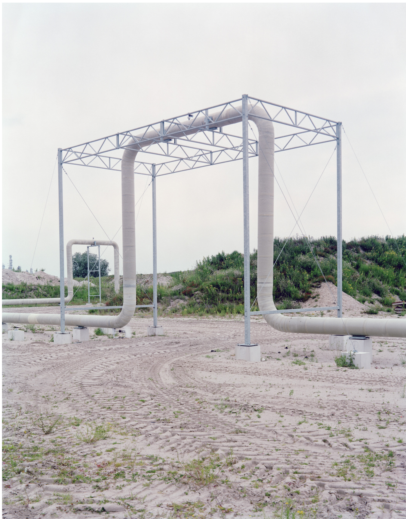
ZUIDELIJKE RANDWEG / MOERDIJK / NOORD-BRABANT / NETHERLANDS / 2013
